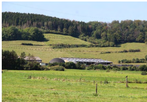
Figure 117 : Installation de biométhanisation à Mullendorf (Photo Luxplan 2021)
