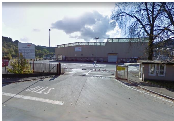
Figure 25 : Site Arcelor-Mittal à Dommeldange (Photo Google SV 2009 – à refaire)
