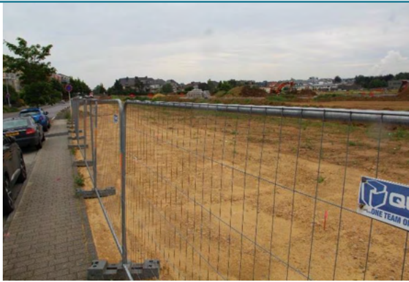
Figure 14 : Nouveau quartier en construction à Strassen (Photo Luxplan 2021)
