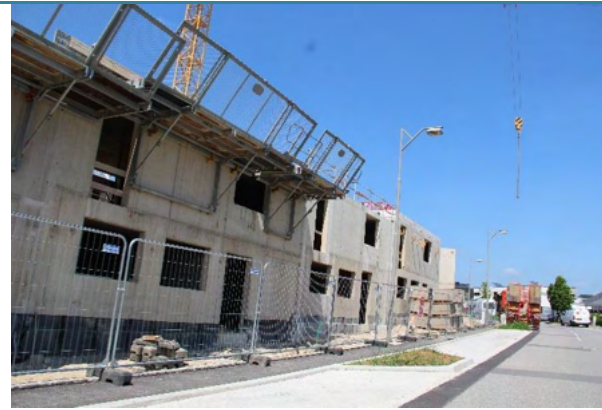
Figure 15 : Nouveau quartier en construction à Oberanven (Photo Luxplan 2021)
